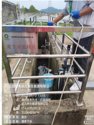
★废水采样点 - 清静下水取样点
